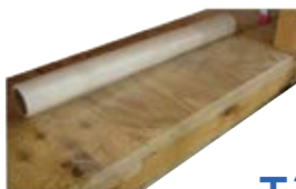
半透明で下地確認
