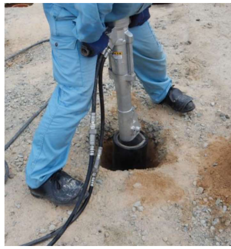
油圧杭打機をセット
